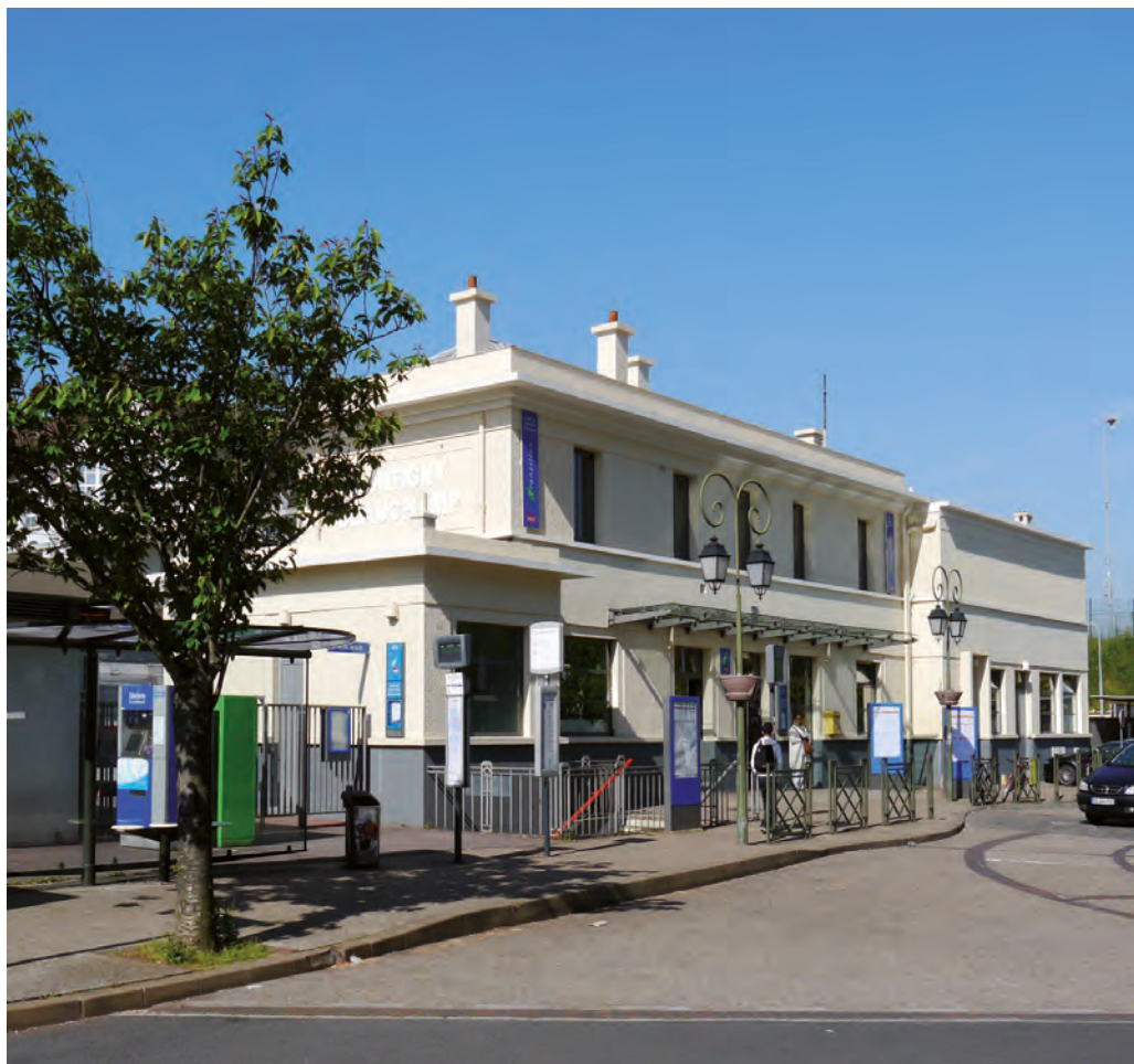
Les travaux de mise en accessibilité de la gare de Montigny-Beauchamp vont durer seize mois.
