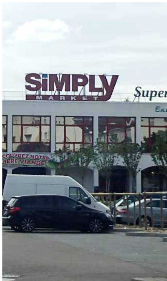
LES ENSEIGNES EN TOITURE
